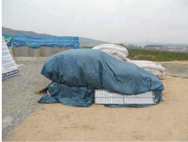
현장 내 자재보관 상태
